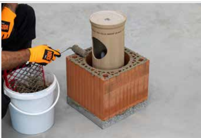
NANÁŠENÍ ZDÍČÍ MALTY NA LOŽNOU SPÁRU
