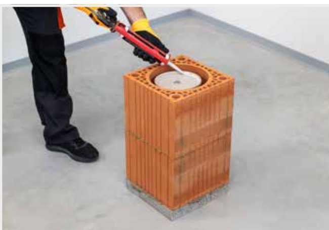
NANESENÍ SPÁROVACÍHO TMELE DO JÍMKY
