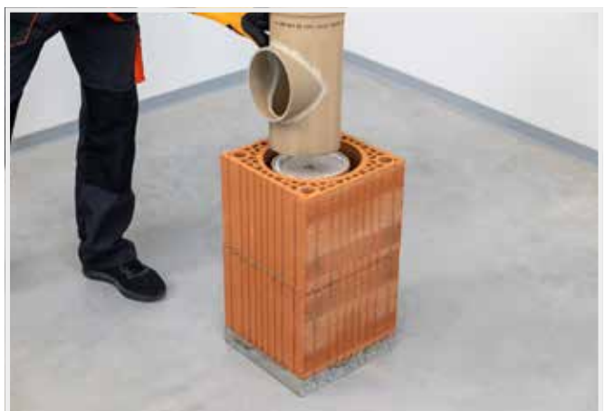
OSAZENÍ VYBÍRACÍHO OTVORU (TVAROVKA BEZ IZOLACE)
