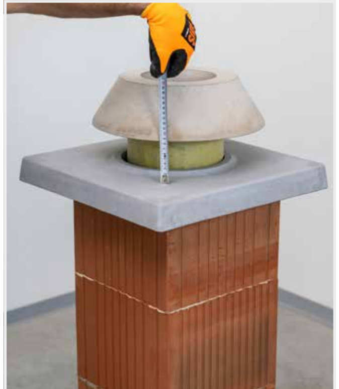
NAMĚŘÍME POTŘEBU ZKRÁCENÍ POSLEDNÍ KOMÍNOVÉ VLOŽKY
