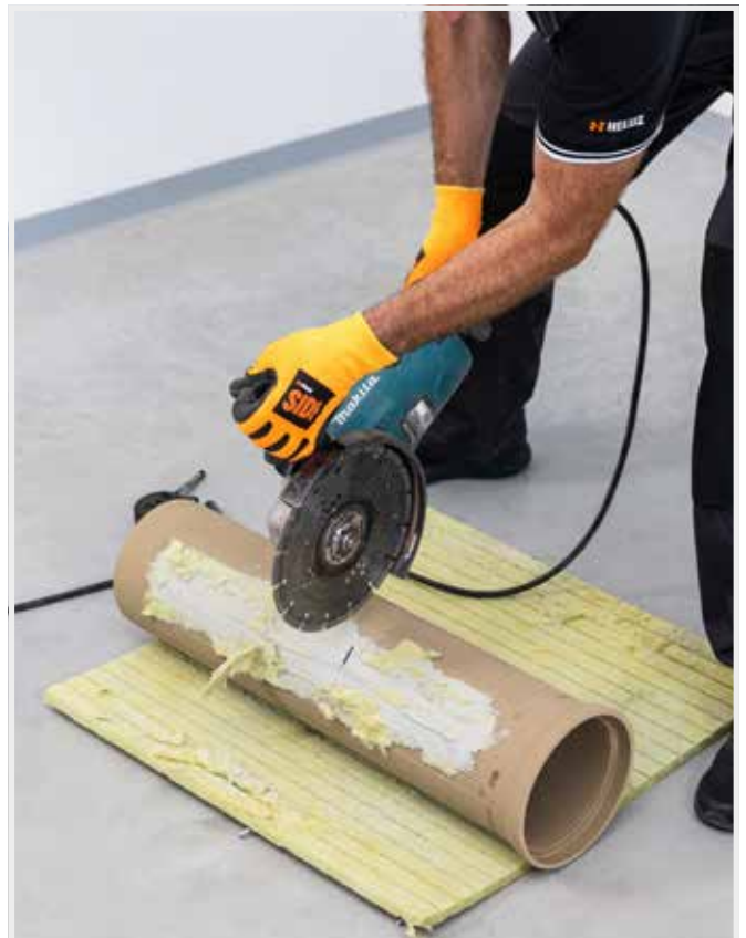
VLOŽKY ŘEŽEME ÚHLOVOU BRUSKOU S VHODNÝM KOTOUČEM
