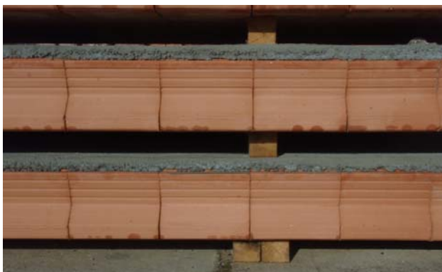
Obr. 9 První panel ve skládce se podkládá dvěma proklady
