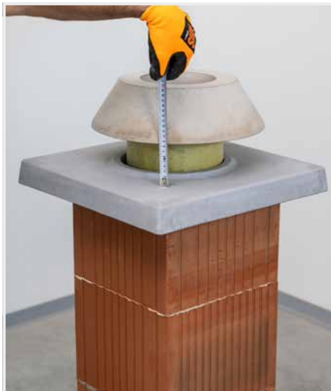
NAMĚŘÍME POTŘEBU ZKRÁCENÍ POSLEDNÍ KOMÍNOVÉ VLOŽKY
