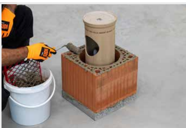
NANÁŠENÍ ZDÍČÍ MALTY NA LOŽNOU SPÁRU
