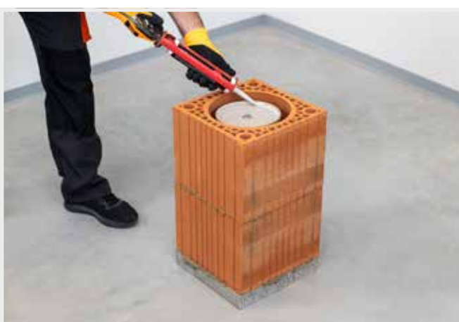
NANESENÍ SPÁROVACÍHO TMELE DO JÍMKY
