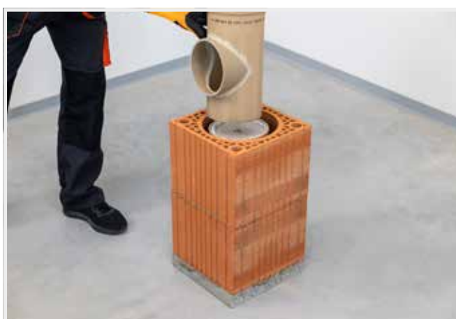
OSAZENÍ VYBÍRACÍHO OTVORU (TVAROVKA BEZ IZOLACE)
