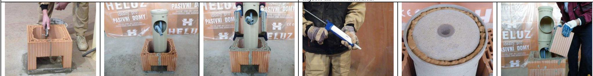
Do středu tvarovek nanese lepicí maltu, do které umístíme kondenzátní jímku (HFJ) hrdlem nahoru. Odtok kondenzátu zajišťuje vrapová pružná hadice umístěná uvnitř jímky. Z té vytvoříme tzv. sifon s hladinou přepadu min. 15 cm, a připojíme do kanalizace, nebo neutralizační jímky.
