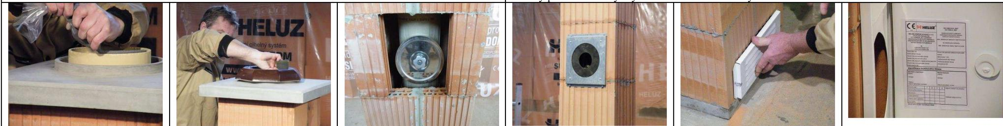
Komínovou vložku očistíme, nanese spárovací hmotu a osadíme komínový límec (HUL). Přebytečnou spárovací hmotu otřeme houbičkou. Mezi vrchní hranou krycí desky a spodní hranou límce (klobouku) musí zůstat mezera 15 mm zajišťující odvětrávání. Dvířkovou tvarovku osadíme kontrolním uzávěrem (HFA).
