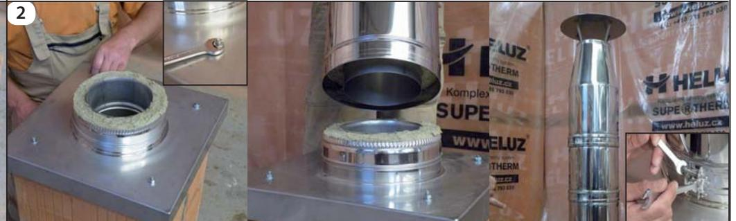
**2** Po vytvrnutí závitkové hmoty osadíme vynášecí díl, který připevníme k závitovým tyčím pomocí dodaných matek. Následně osazujeme díly nerezového nástavce (HXD), vždy částí s menším množstvím tepelné izolace směrem dolů. Spoj opatříme sponou (HXJ) a dotáhneme. Nástavec vystavíme do požadované výšky a zakončíme ho koncovým dílem (HXG), případně koncovým dílem s Meidingerovou hlavou (HXGM). K upevnění uzemnění použijeme zemnicí objímku (HXZ).
