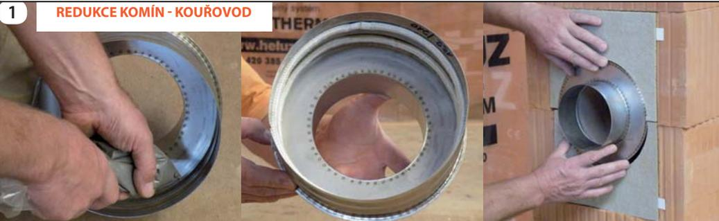
Do drážek v redukci komín/kouřovod (HRK) nanese pomocí dodaného pytlíku (HPH) spárovací hmotu (HHS) připravenou podle návodu na obalu. Těsnící provazec, který je součástí dodávky, vložíme do drážek se spárovací hmotou a necháme jeden den zatvrdnout. Upravíme čelní izolační desku (HIB) a redukci zvenku nasuneme na ústí soughu. Následně můžeme připojit kouřovod.
