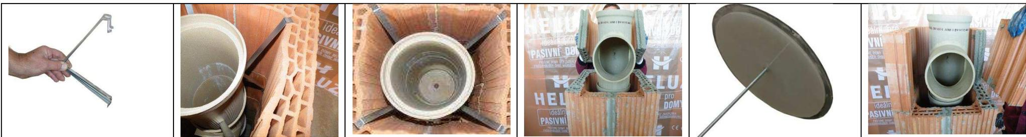
Po vystavení zhruba dvou metrů komínu je nutné vystředit komínové vložky pomocí distanční sady (HOD). Do otvorů v rozích cihelných komínových tvarovek umístíme jednotlivé distanční díly tak, aby spalinová cesta byla přímá a ve středu komínového tělesa. Ložné plochy již osazených tvarovek, stejně tak i ložné a styčné plochy nově osazovaných tvarovek očistíme, nanese na ně lepicí maltu a dále pokračujeme ve zdění. Opakujeme po každých dvou metrech komínu.
