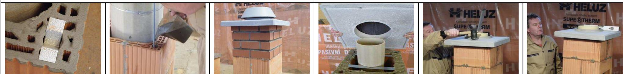
Pokud je nadstřešní část komínu vyšší než 1,3 m nebo je vystavěná z prstenců GRAND (HCP, HCB), je nutné použít zpevňovací výztuž (HZV), jejíž délka odpovídá dvojnásobku výšky nadstřešní části. Proto je nutné si dopočítat výšku, ve které osadíme do cihelných komínových tvarovek zaslepující plíšky a začneme s výstavbou výztuže. Detailní postup naleznete v montážním návodu na nadstřešní části.
