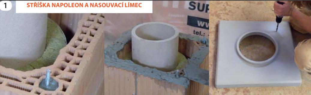
Cihelné tvarovky vyzdíme do požadované výšky a zpevňovací výztuž (sestavenou podle návodu výše) seřízneme tak, aby vyčnívala nad krycí desku pro uchycení stříšky Napoleon (HUN, HUNM). Závitové tyče vystředíme a zalijeme závitkovou hmotou. Poslední řadu cihelných tvarovek navlhčíme a nanese na ní minimálně 0,5 cm vrstvu lepicí malty, do které pak osadíme krycí desku.
