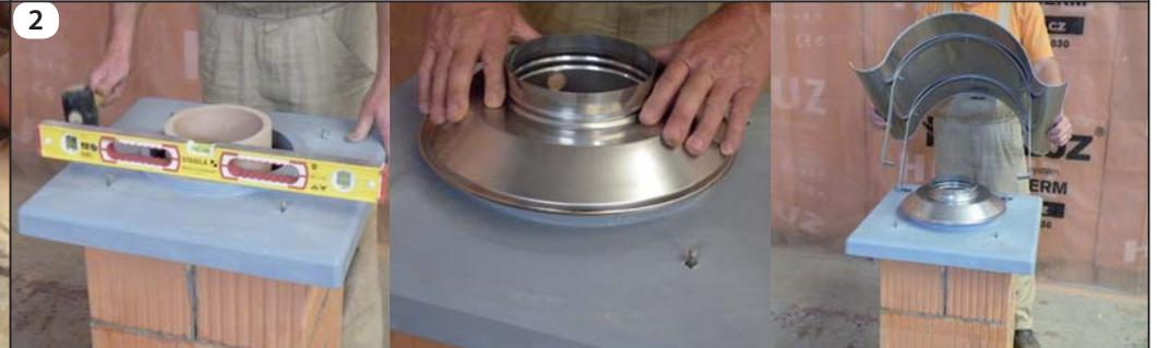
Osadíme krycí desku a vyrovnáme ji pomocí gumové paličky a vodováhy. Následně osadíme komínový límec (viz návod ke komínovému systému). Pokud se jedná o nerezový límec nasouvací (HULN), nepoužijeme spárovací hmotu, ale límec pouze nasuneme na komínovou vložku.
